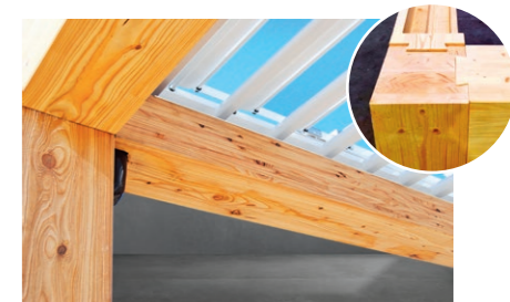
Schwalbenschwanz-Verbindungen
